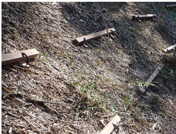
図 6.3-2 道路法面での足場の設置例
