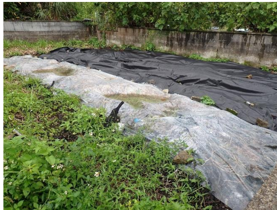
防草シート（奥）・透明シート（手前）の設置実験の様子
