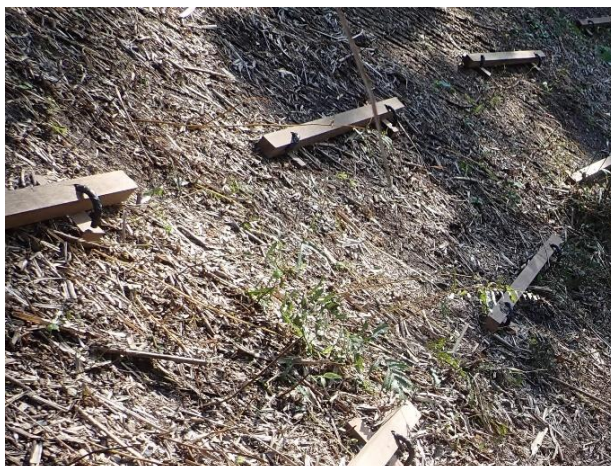
図 5. 2-2 道路法面での足場の設置例
